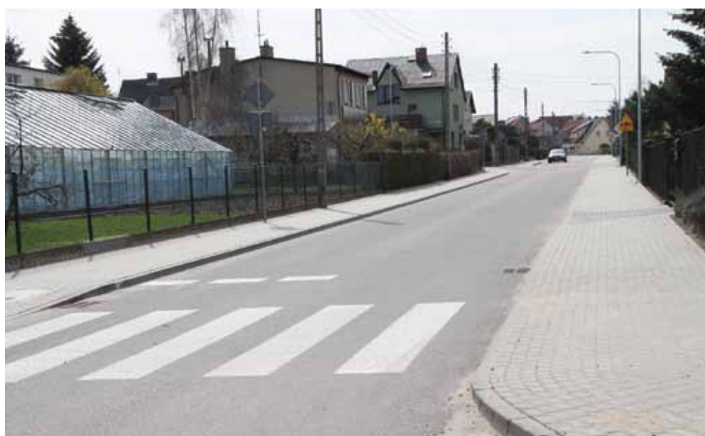
Przebudowaliśmy na os. Staszica ul. Stoczniowców, na Czyżykowie - Pułaskiego, na os. Prątnica - Zygmunta Starego (na zdjęciu),
