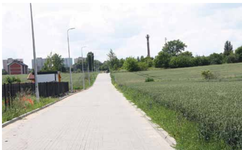
Przebudowaliśmy ul. Retmańską (na zdjęciu) – łącznik między os. Staszica a Zatorzem. W trakcie realizacji jest przebudowa ul. Królowej Marysieńki i remont ul. Kwiatowej .
